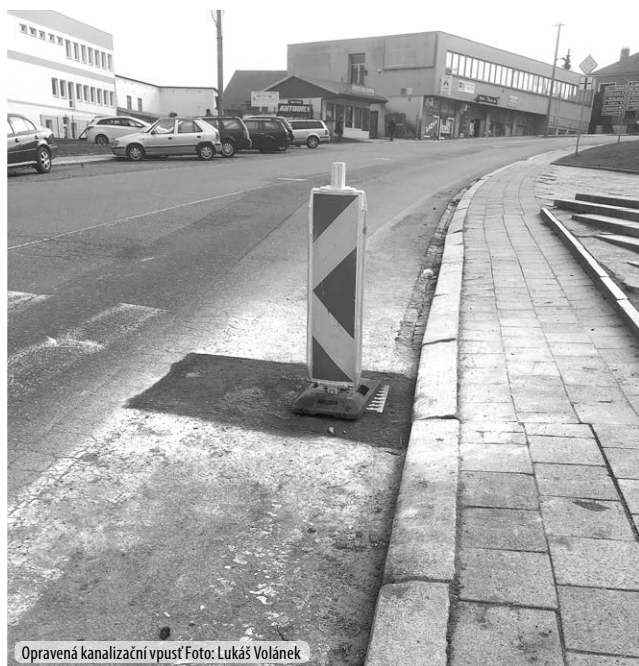
Opravená kanalizační vpusť Foto: Lukáš Volánek
