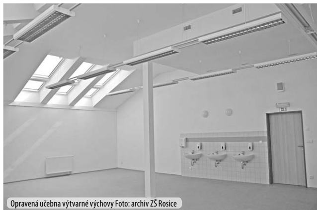
Opravená učebna výtvarné výchovy Foto: archiv ZŠ Rosice
