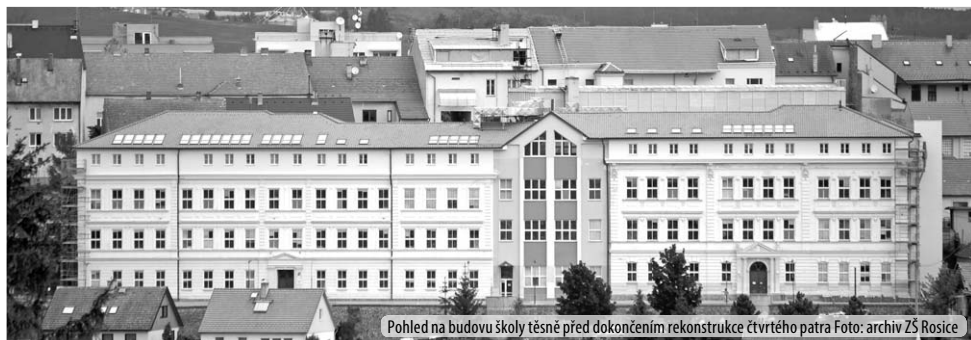
Pohled na budovu školy těsně před dokončením rekonstrukce čtvrtého patra Foto: archiv ZŠ Rosice
