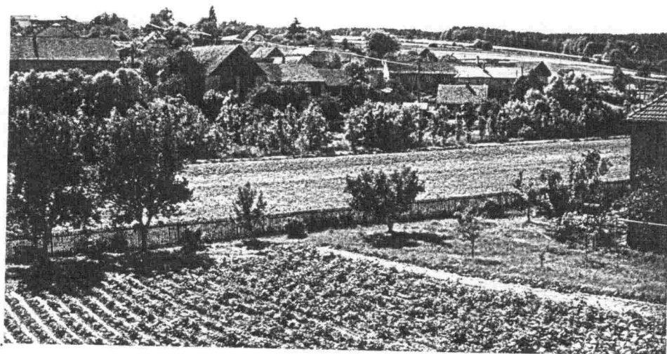
16 NIVA POTOKA BÍLÁ VODA V PROSTORU OBCE OD VÝCHODU
